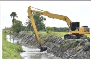
ปรับปรุง ทางระบายน้ำ
