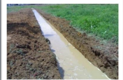
ดูแลระบายน้ำให้ใช้งานได้
