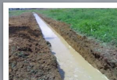
ทำทางระบายน้ำ
