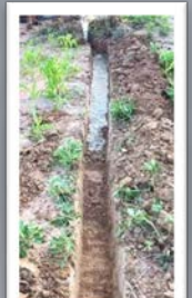
ทำทางระบายน้ำออก
