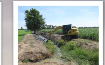
ทำทางระบายน้ำออก
