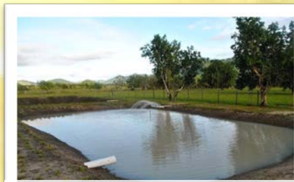
ไม่ควรให้น้ำฝนตกบนดินไหลลงบ่อ
