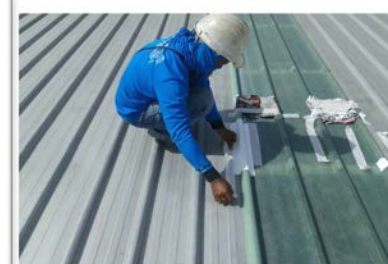
ซ่อมแซมรอยรั่วซึม
