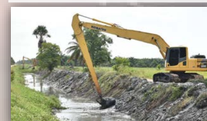
ดูแลทางระบายน้ำ
