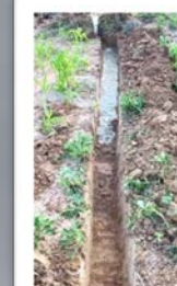
ทำทางระบายน้ำ
