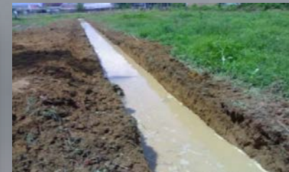
ทำทางระบายน้ำ
