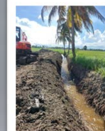
ทำทางระบายน้ำ
