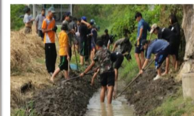
ทำทางระบายในพื้นที่ลุ่มต่ำ
