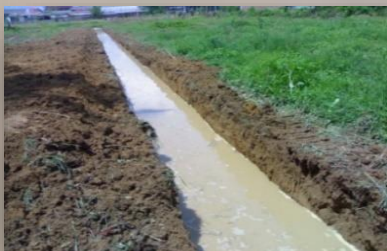
ทำทางระบายน้ำ
