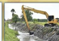
ทำทางระบายน้ำ
