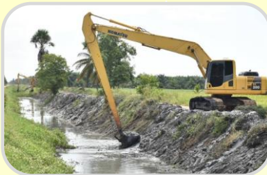
ทำทางระบายน้ำ เพื่อป้องกันน้ำท่วมขัง
