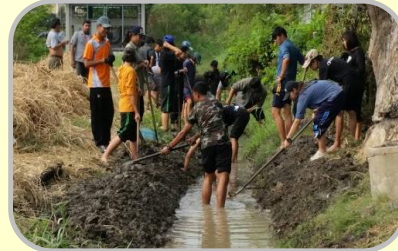
ทำทางระบายน้ำ เพื่อป้องกันน้ำท่วมขัง
