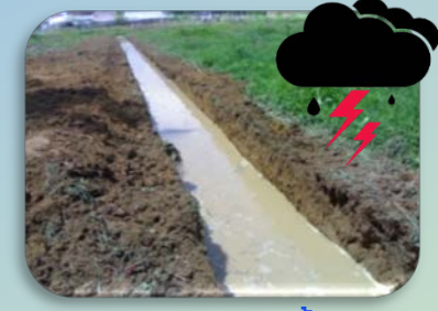
ทำทางระบายน้ำ
