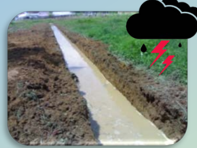
ทำทางระบายน้ำ
