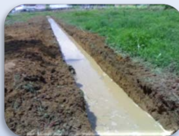
ทำทางระบายน้ำ
