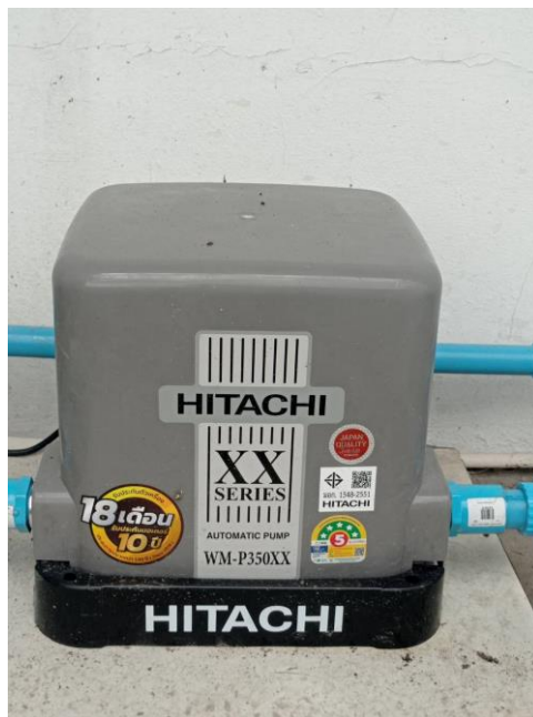
ปั้มน้ำอัตโนมัติ ยี่ห้อHITACHI รุ่น WM-P350XX
