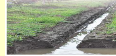
ปรับปรุงซ่อมแซม ระบบระบายน้ำ
