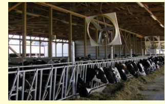
ติดตั้งพัดลม เพื่อคลายความร้อนอบอ้าวในโรงเรือน
